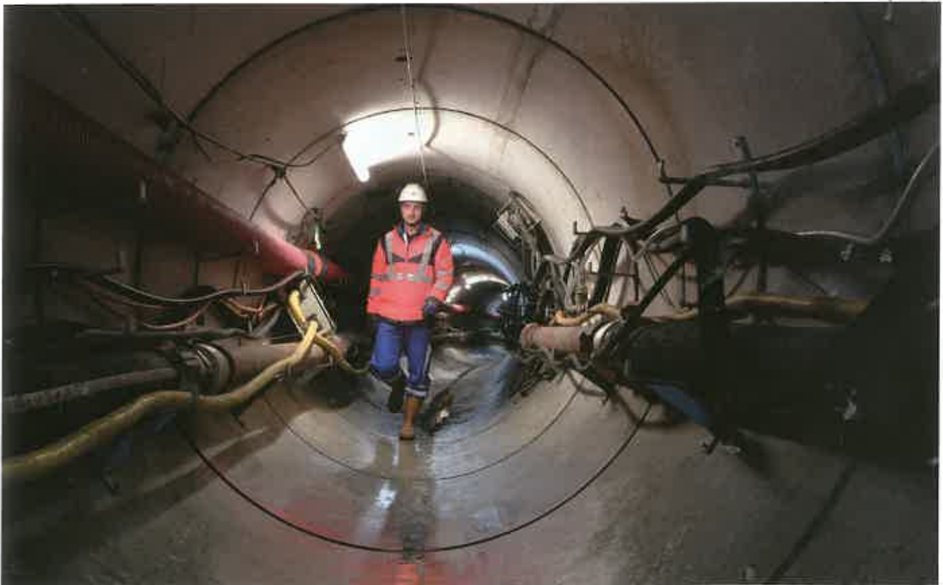
Figure 4 : Vue intérieure du collecteur Ø 2400 mm en cours de fonçage [Photo Crédit SADE] / Internal view of 2400 mm main during jacking [Photo credit SADE]
