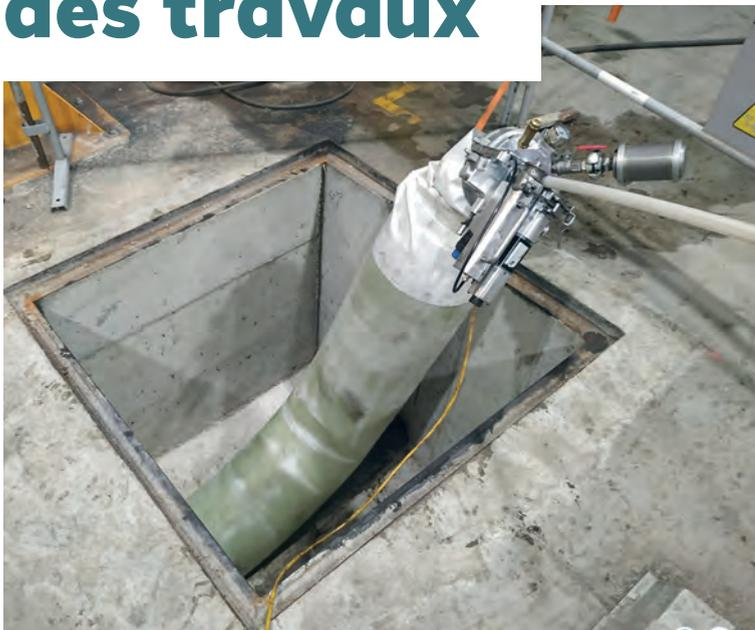
Au Creusot sur le site de fabrication des bogies\* d'Alstom, SADE Travaux Spéciaux a été mandatée pour la réalisation de la troisième phase de travaux de réhabilitation du collecteur d'eaux pluviales du bâtiment de soudure ♦
