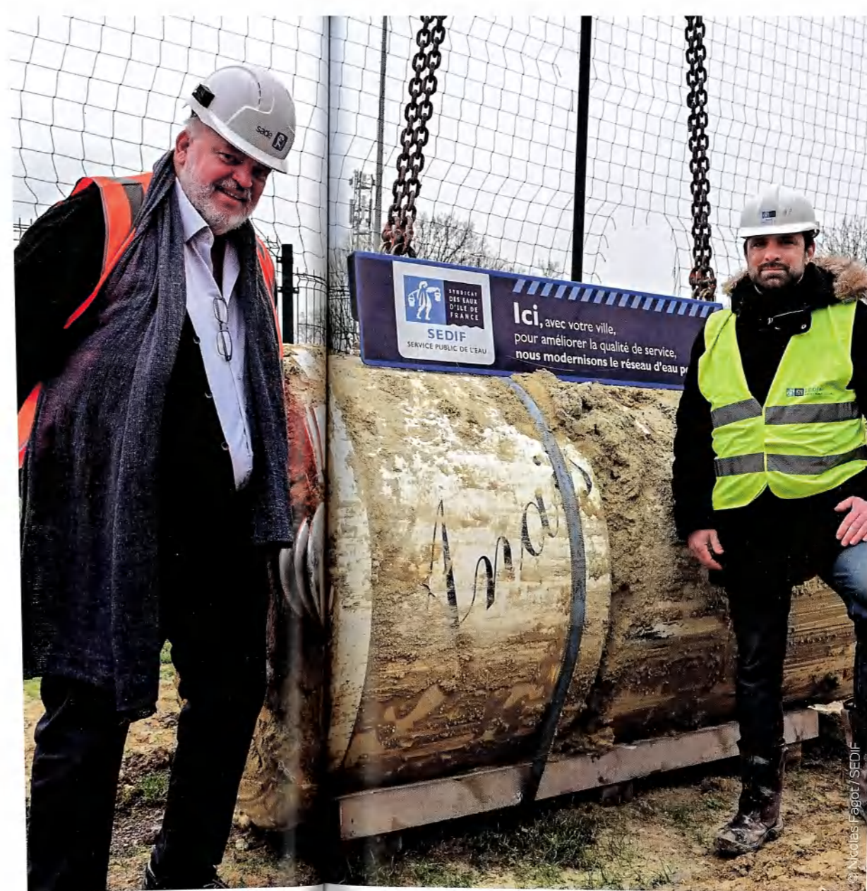
▲ Fin de parcours pour le microtunnelier Anais en janvier 2022 à l'occasion d'un chantier de renouvellement d'une canalisation DN 600 entre Frépillon et Beauchamp (Val-d'Oise).
