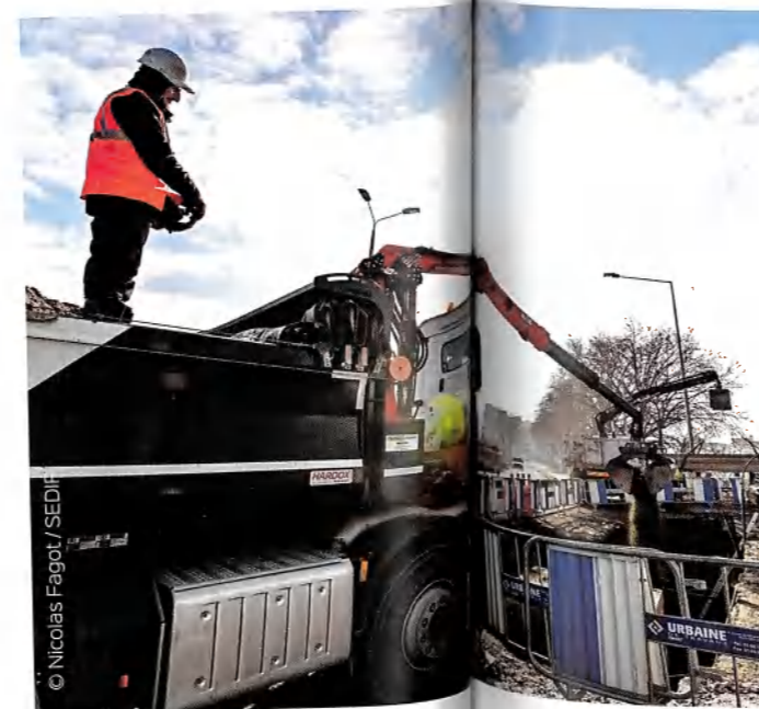
▼ Remplacement d'une canalisation à l'Île-Saint-Denis dans le cadre des Jeux olympiques 2024.
