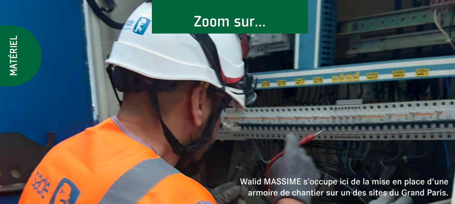
Walid MASSIME s'occupe ici de la mise en place d'une armoire de chantier sur un des sites du Grand Paris.
